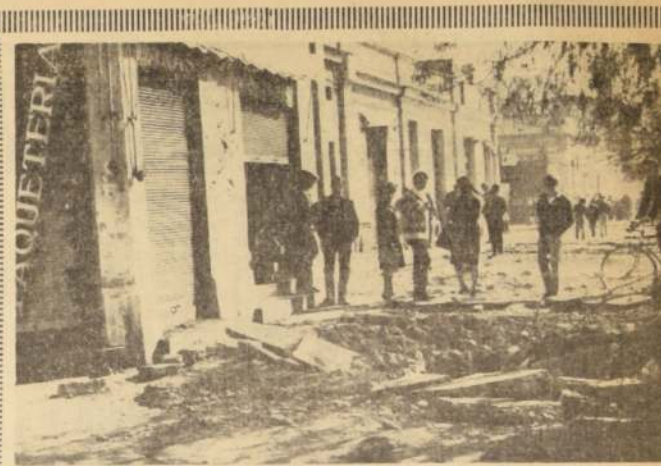
Gases acumulados en cámaras subterráneas de las Compañías de Electricidad y de Gas, provocaron violentas explosiones en tres puntos de Independencia, causando cuantiosos daños materiales. La escena muestra un aspecto de la fuerte onda expansiva, que quebró vidrios, vitrinas, carteles y destruyó calzadas, en J. Vial e Independencia.
