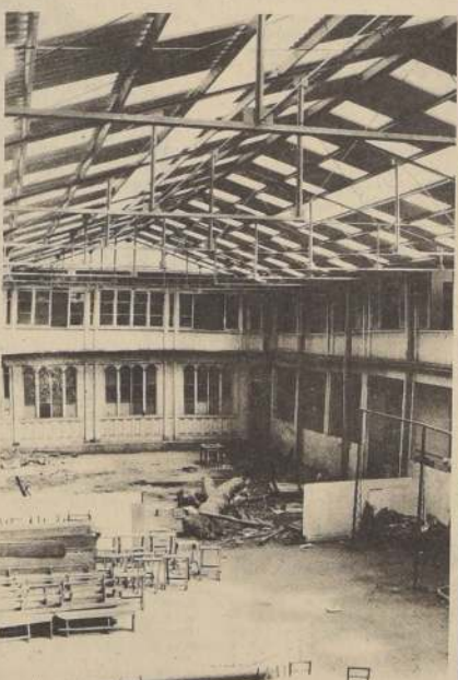
La cubierta de plástico y pizarra para el amplio patio de la Casa del Boxeador, permitirá la instalación de tres nuevos cuadriláteros.
