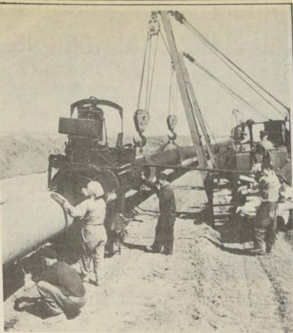
Obras de agua potable que beneficiarán a localidades comprendidas entre la VI y la X Región, significarán un alivio para miles de familias en lo que el Gobierno está empeñado. En la foto, parte de trabajos ya en realización.
