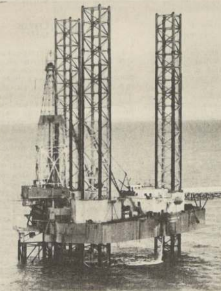
Plataforma de exploración petrolera "Nugget", que trabaja delimitando los yacimientos existentes en Magallanes, para determinar dónde deben ubicarse las plataformas fijas, de las que se perforarán nueve o diez pozos.
