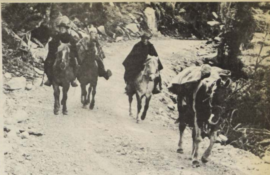
Un aspecto del tramo "Huella de Pilcheros" que recientemente terminó de construir la Dirección de Vialidad en el Longitudinal Austral.
