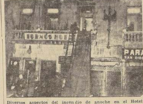
Diversos aspectos del incendio de anoche en el Hotel Fornos.
