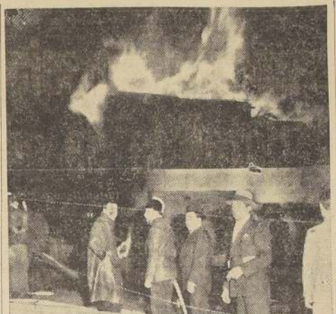
Diversos aspectos del incendio de anoche en el Hotel Fornos.
