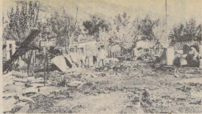
Se inició la labor de despeje de escombros en la población Huamachuco luego que un siniestro destruyera 13 viviendas.
