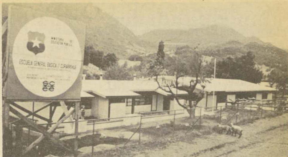
VISTA PARCIAL DE las instalaciones de la Escuela Fronteriza de Concentración en la localidad de Curarrehue, 15 kilómetros al interior de Pucón.
