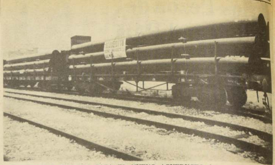
LAS GRANDES TUBERIAS PARA EL NUEVO ACUEDUCTO de Calama a Antofagasta aparecen en los momentos en que eran trasladadas desde la usina brasileña que las fabricó, hacia el puerto para ser embarcadas con destino a Chile.
