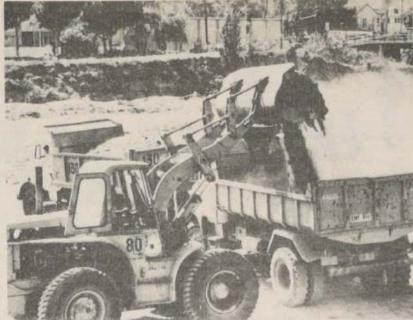
VIÑA DEL MAR. — Se inició el operativo de limpieza del cauce del estero Marga Marga, en el sector urbano de la Ciudad Jardín. Maquinarias pesadas de la Municipalidad realizan las faenas, para dejar totalmente limpio de escombros, basuras y malezas el lecho fluvial, además de ser desratizado.
