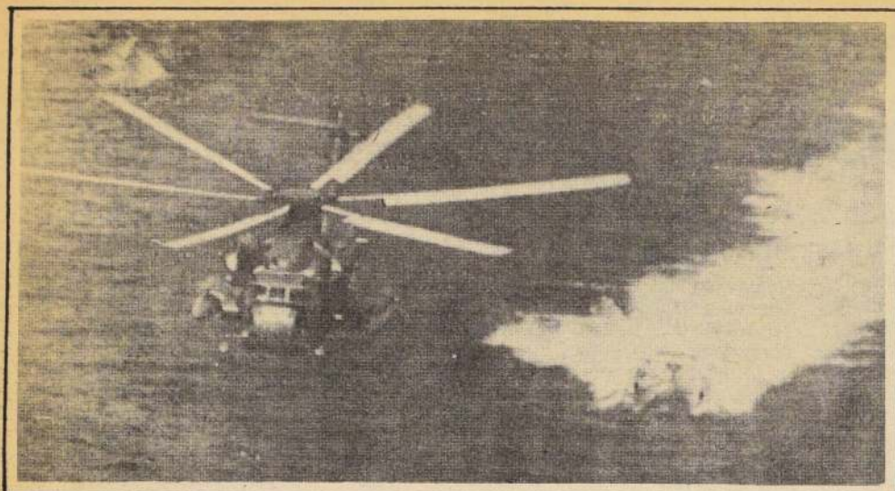
Foto de archivo divulgada por el Departamento de Defensa de EE.UU. que muestra un helicóptero RH-53D que arrastra un barreminas magnético por la superficie del agua durante ejercicios militares realizados cerca de la costa española en diciembre de 1981. El Pentágono anunció que varios de éstos serán enviados a Egipto. (Radiofoto AP).
