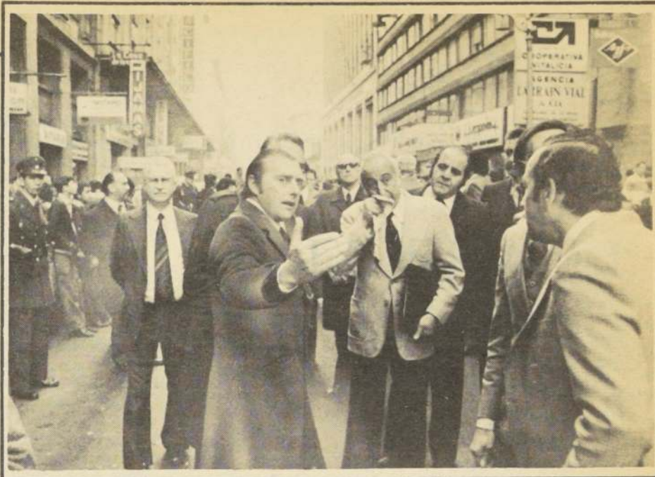
EL ALCALDE PATRICIO GUZMAN, junto a arquitectos y comerciantes del sector inauguró ayer la iniciación de los trabajos de calle Huérfanos. El paseo se extenderá entre Estado y Morandé en un primer tramo, para abarcar posteriormente desde el Cerro Santa Lucía a la carretera Norte-Sur.
