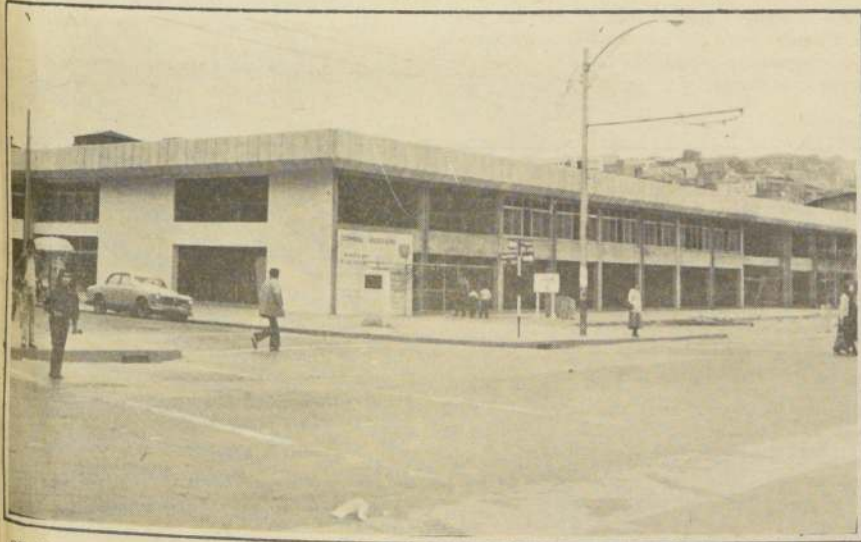
SE ESTA TRABAJANDO en forma acelerada en las terminaciones de la Estación Rodoviaria de Pedro Montt esquina Rawson, para entregarla a la ciudad el 11 de septiembre próximo. La foto muestra el estado actual de los trabajos.
