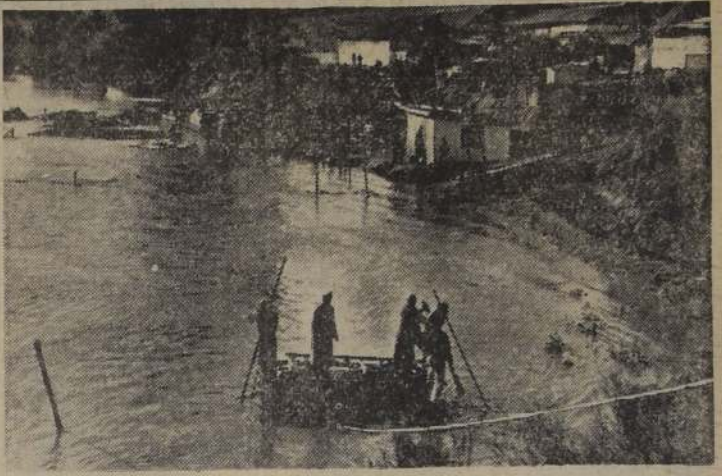
TRANSPORTAN PUENTE DESARMABLE. — Conscriptos de la Escuela de Ingenieros Militares de Tejas Verdes, al mando del mayor don Enrique Zúñiga, en una palia neumática, conectada a cables de acero, transportan por el río Maipo, cerca de su desembocadura en San Antonio, las partes esenciales de la estructura de un puente metálico, que será armado hoy sobre el camino longitudinal, en el tramo Rosario-Rengo. Con esta obra se normalizará el tráfico carretero al sur del país.
