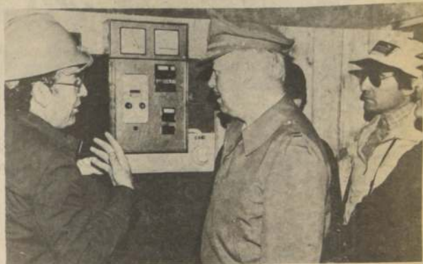
El ingeniero de la Planta explica al Intendente Prüssing el manejo del tablero de comando. Observa José Genta, Director Regional de Vialidad.
