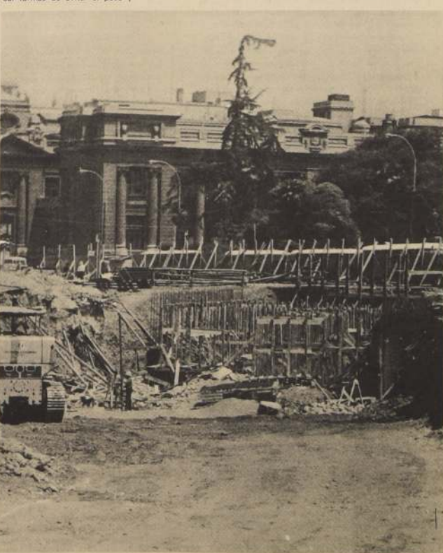
Por debajo de la Alameda las máquinas comienzan a abrir la arteria subterránea que descongestionará el centro de la capital.
