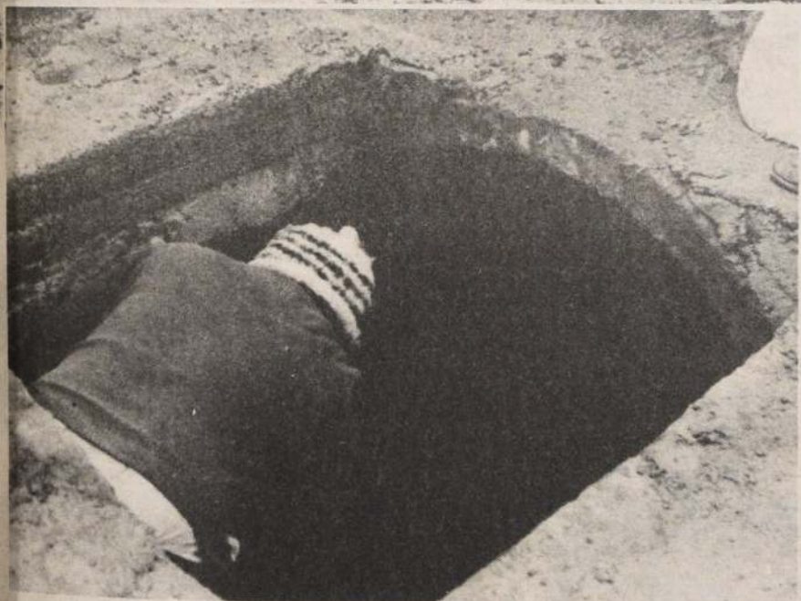
La limpieza de alcantarillado es un trabajo que se efectúa con gran periodicidad en la comuna, de tal forma de evitar anegamientos que interfieren en la normal vida de la comunidad.
