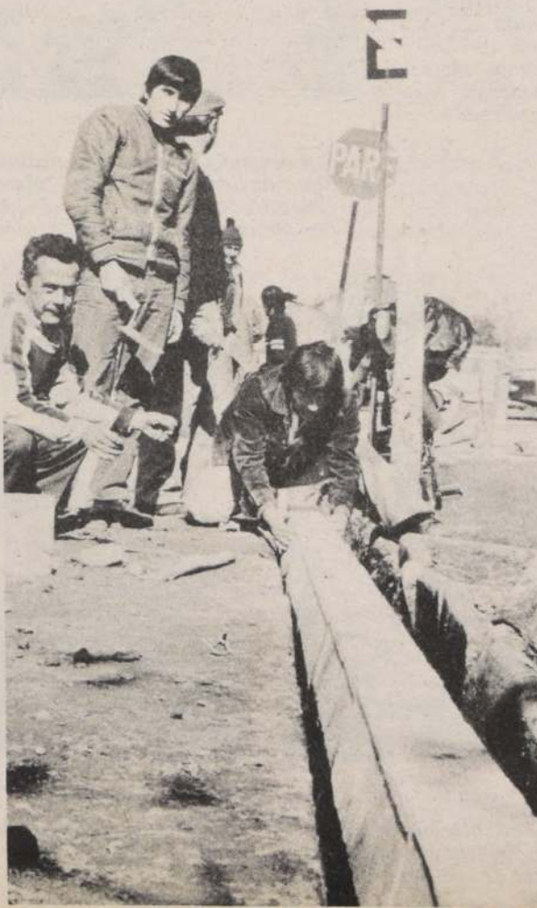
La construcción de soleras es una tarea que lleva a cabo el POJH en San Miguel.
