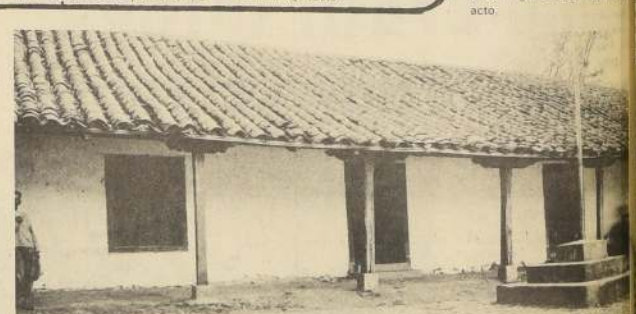
ESTA ES LA CASA colonial en que nació Arturo Prat en el fundo Ninhue, que pertenece a la ruta turística que presentará la Armada en la Biblioteca Nacional del 1 al 25 de mayo próximo.
