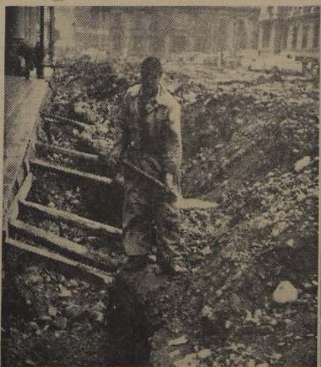
EL UNICO TRABAJADOR.— Oscar Garrido, de 34 años de edad, es el único operario de la Compañía de Agua Potable de Santiago que ayer martes 22, a las 16 horas, se encontraba trabajando en el sector comprendido entre las calles, Bandera y Morandé, en la colocación, empuje y traslado de las redes subterráneas que es necesario completar para iniciar los trabajos de pavimentación de la calle Compañía. Esta foto es un documento gráfico irrefutable de la inexplicable lentitud con que las compañías de servicios públicos y la Dirección de Pavimentación de Santiago, se han abocado a las obras proyectadas en esta importante arteria.
