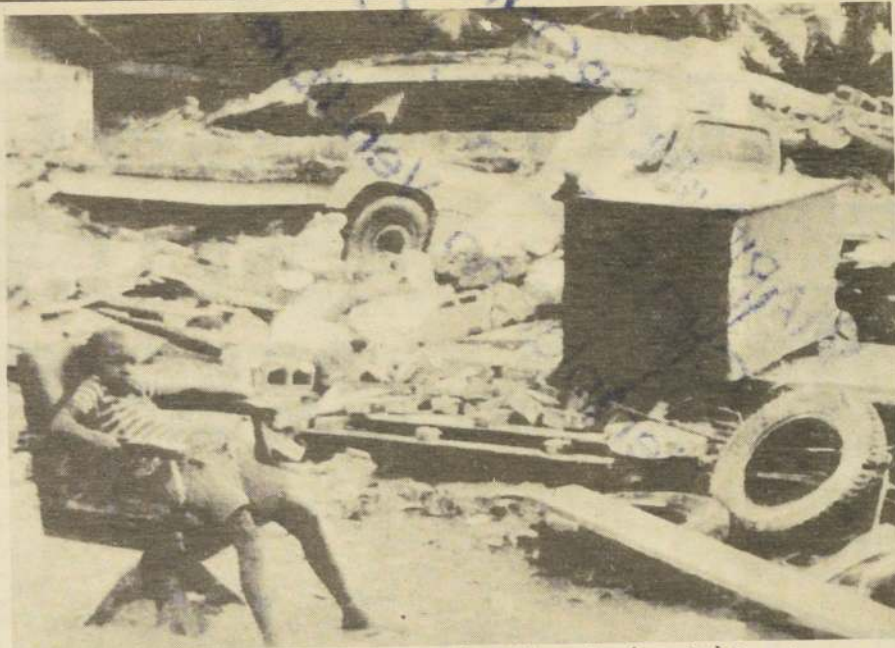
TUMACO, COLOMBIA.— Todo quedó destruido, lo único que se mantuvo en pie en esta casa es lo que se aprecia en la fotografía, (UPI).
