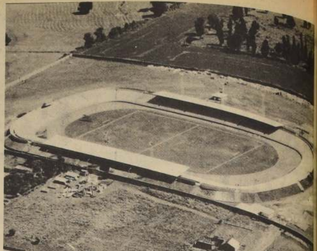
NO SERÁN ESTADIOS HERMOSOS, como este de Temuco, lo que dará el Plan de Canchas para Chile, pero permitirá a los clubes tener una cancha con drenaje, riego y camarines para poder entrenar. Hoy parten las visitas de los inspectores.
