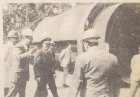
El Ingeniero Jorge Anwandter, Gerente General de Maestranza Maipú, explica al General Leigh las características del primer Convertidor de cobre fabricado en Chile. El tamaño de la gigantesca estructura se observa a simple vista.
