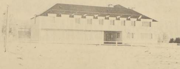
El caserón de Epalinges, a pocos kilómetros de Lausanne. Un inmueble fácilmente transformable en hospital.
