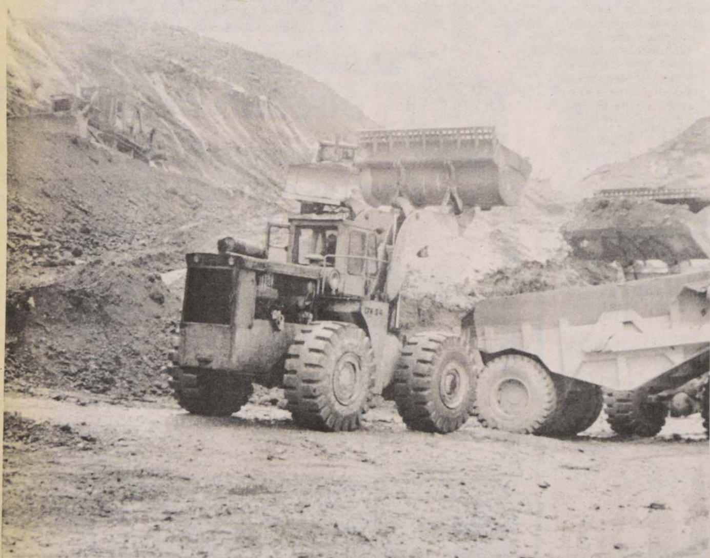
Un aspecto de las obras en Sector-Sur: Durante 1985 se realizaron importantes inversiones en equipamiento de explotación a cielo abierto de este mineral.
