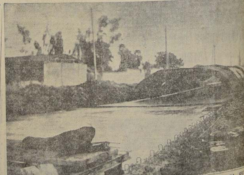
UN TROZO DEL CAMINO RECIEN TERMINADO Y PROTEGIDO CON UNA CARPA PARA QUE EL CONCRETO FRAGUE BIEN. DESPUES, DURANTE 21 DIAS, SE LE CUBRE CON SACOS HUMEDOS QUEDANDO LISTO PARA EL TRANSITO.
