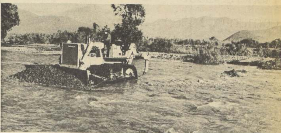
Trabajos de encauzamiento del río Ligüa y estero Cerrado, en la provincia de Petorca inició la Dirección de Vialidad a través del Departamento de Obras Fluviales. Todos ellos están destinados a defender badenes y puentes del sector. Los trabajos cubrirán una longitud de 1.150 metros.
