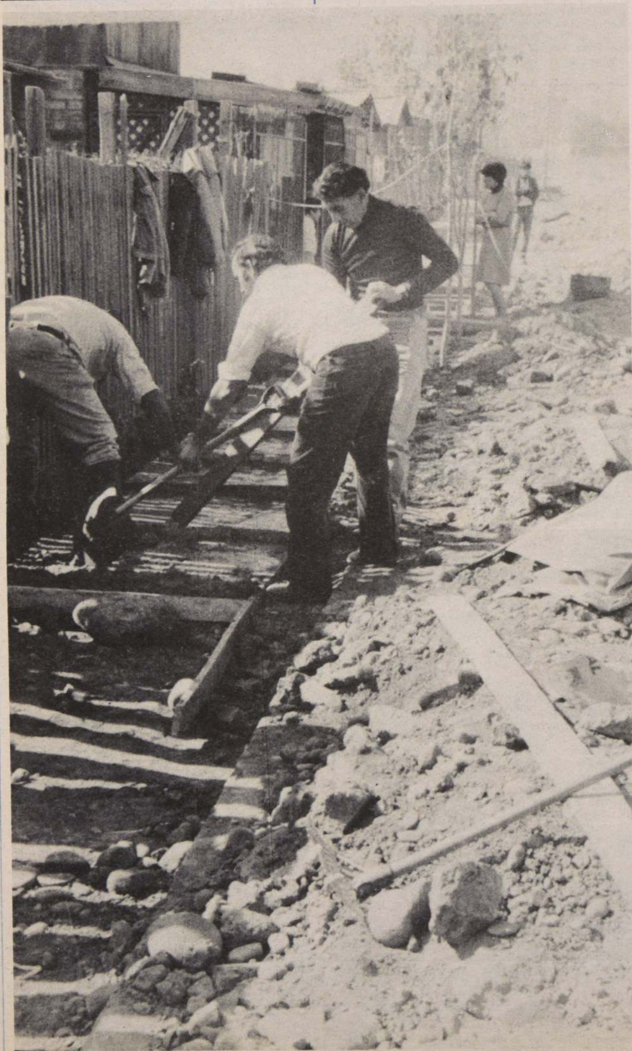
La construcción de veredas se realiza con mano de obra de los propios vecinos. En el municipio todos se ayudan a sí mismos.
