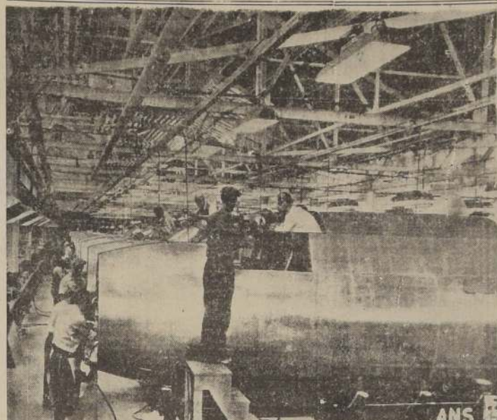
Vista parcial de la línea de montaje de la planta Chrysler de Sofo, E. Unidos, donde se fabrican ahora bombarderos medianos. Esta fábrica entró en producción los cinco meses después que recibió los planos para su levantamiento. (Servicio Gráfico A. N. Saporiti)
