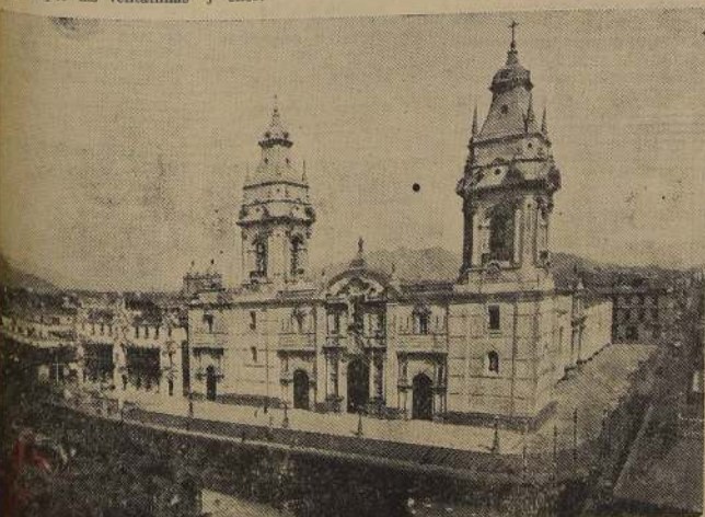
La centenaria Catedral de Lima, cuyas dos torres se derrumbaron a causa de la violencia del sismo registrado ayer en Perú
