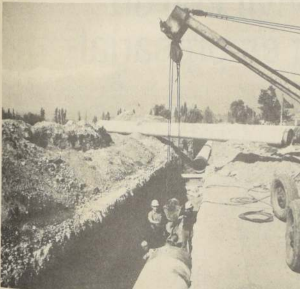
La Planta Alimentadora de Agua Potable Trinidad, donde se construye e instala la tubería necesaria para prestar beneficios a un amplio sector de población residente en las comunas de La Florida, Cisterna y La Granja, realizará un recorrido de nueve kilómetros llevando el vital líquido a un grupo poblacional que siempre tuvo dificultades de abastecimiento en verano. La fotografía corresponde al tramo Macul-Vicuña Mackenna.
