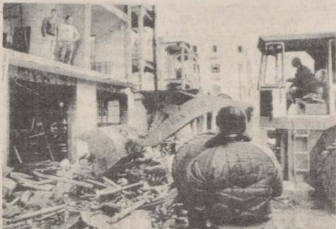
Dos civiles que sobrevivieron a un atentado dinamitero en Beirut Oriental, luego que estallara un auto cargado con bombas, observan cómo son demolidos los restos de un edificio, primer blanco del estallido (Radiofoto Reuter).
