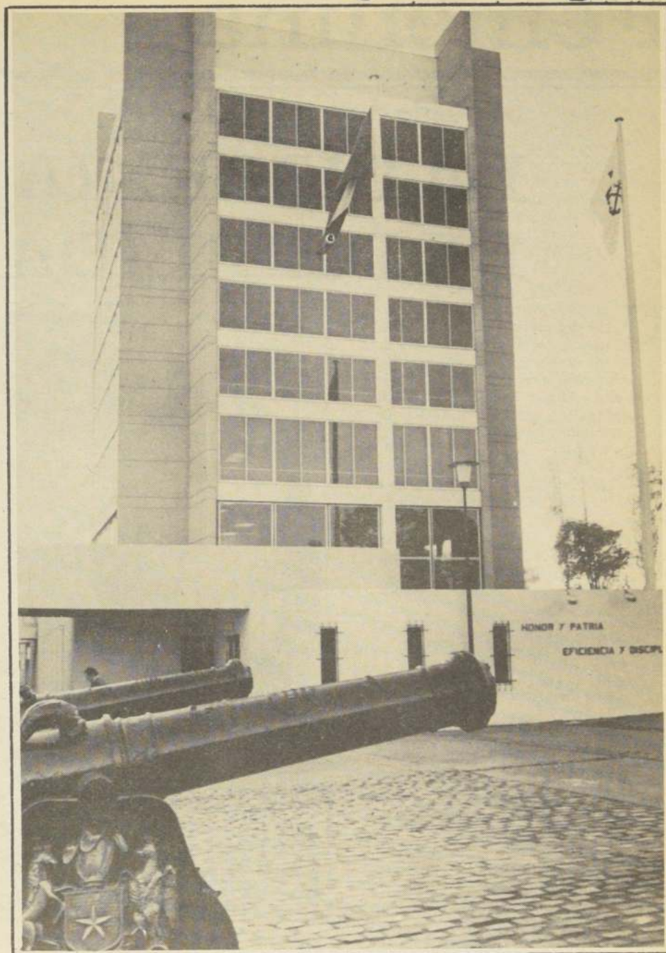
TORRE DE LA Dirección y Oficinas Administrativas de la Escuela Naval, que se inaugura hoy.
