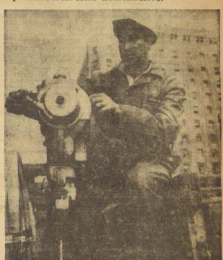
En el grabado aparece la perforadora "Cobra", fabricada por Atlas Copco. Es la más moderna maquinaria en su tipo. Pesa solamente 24 kilos y funciona con gasolina.
