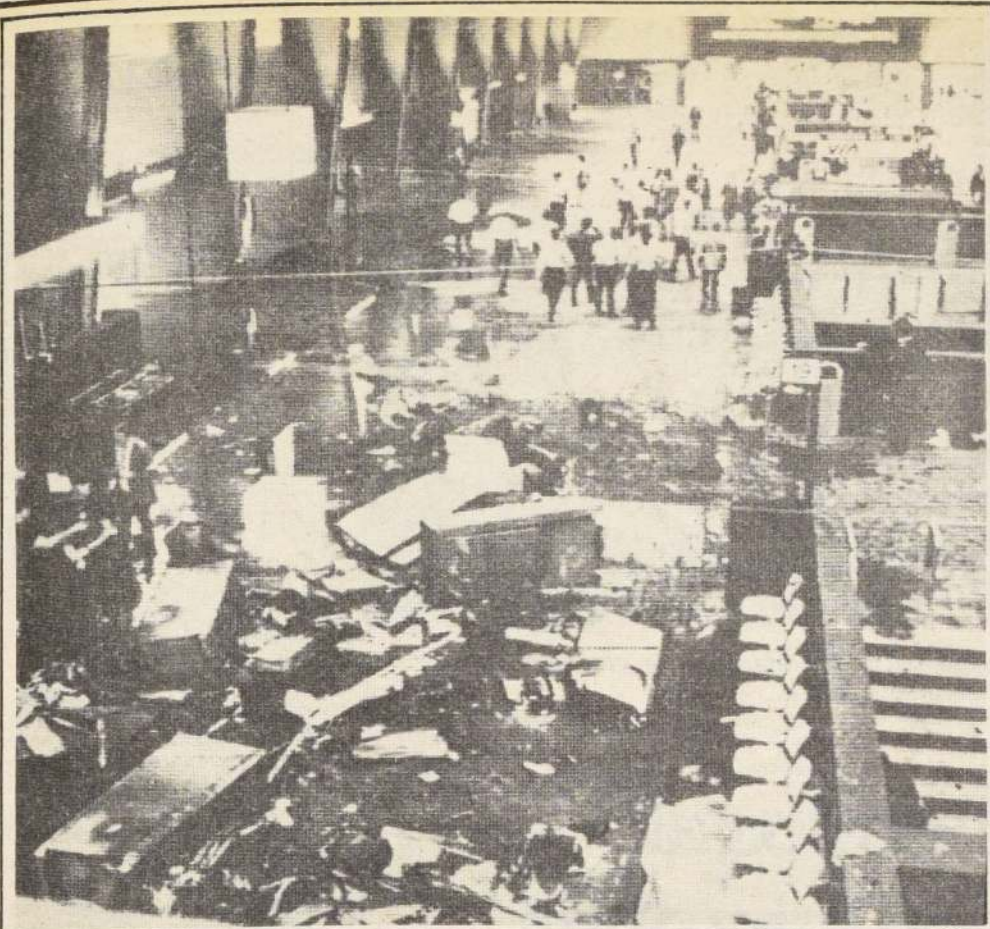
ATENTADO EN MONTREAL. — Aspecto general de los escombros dejados por la explosión de una bomba en la estación central de trenes de Montreal, Canadá, que dejó un saldo de tres muertos y 14 heridos. (AP).
