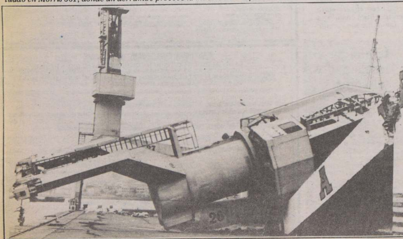
Estructuras agrietadas y una grúa desplomada son testimonios elocuentes de los daños que el fenómeno telúrico causó en el recinto portuario de Valparaíso.
