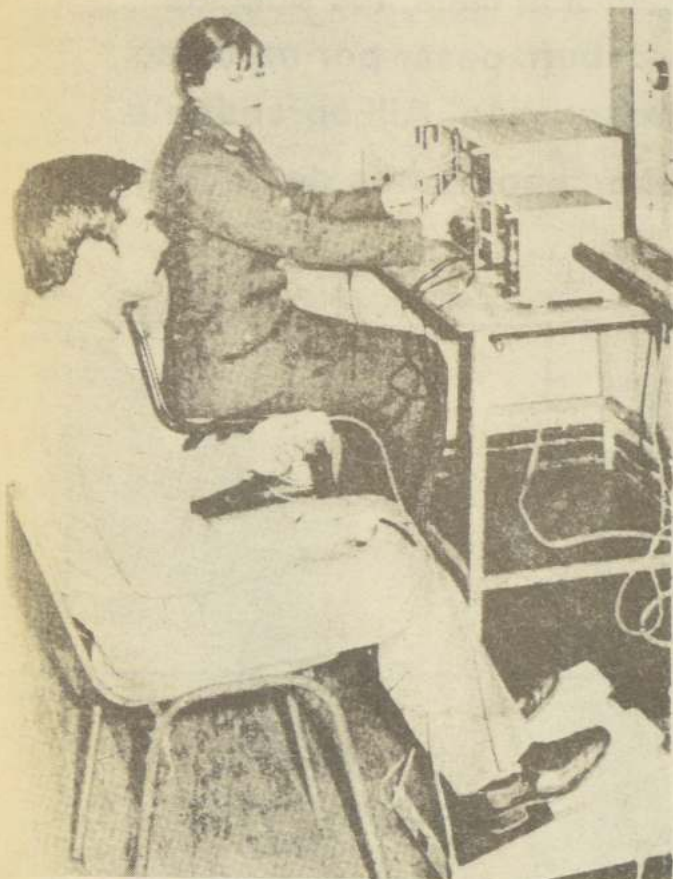
Los reflejos para activar el freno o acelerador son vitales en la conducción. Este aparato mide en décimas de segundo la velocidad de reacción
