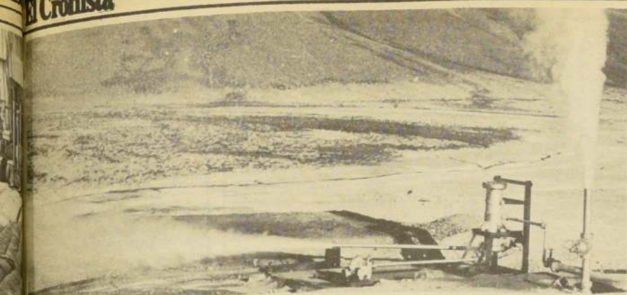
PLANTA GEOTERMI-CA. — Este es el pozo número 2 de Puchuliza en el interior de Iquique, en el que se produjo energía eléctrica con el vapor geotérmico que surge de las entrañas de la tierra.
