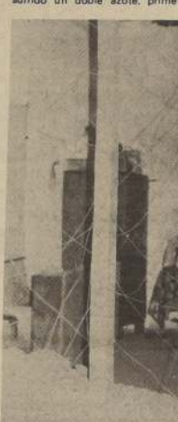
DE LA PARED que divide estas dos viviendas, sólo quedan los alambres que sostenían los adobes.
