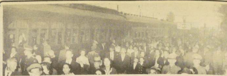
SUPRIMIERON TREN en el sur a pesar de que sirve mucho.
