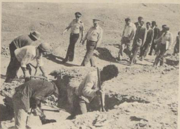
La reparación y construcción de caminos han permitido dar trabajo a numerosos jefes de hogar en la III Región. En la foto, aspecto de la visita realizada por los Subsecretarios de Estado a las obras de apertura de una nueva ruta.
