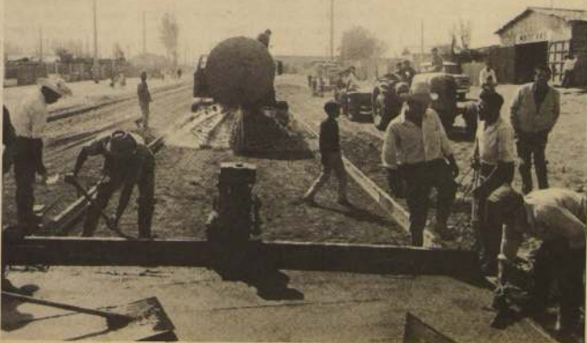
LOS TRABAJADORES completan los últimos tramos de la calle Huérfan, arteria que cruzará cuatro poblaciones.
