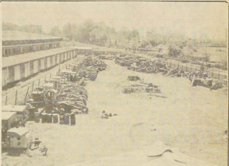
VIALIDAD REMATARA MAQUINARIAS PESADAS. Maquinaria pesada, cuyo valor asciende aproximadamente a unos 4 millones de dólares, rematará próximamente la Dirección de Vialidad, según lo anunció ayer su Director, ingeniero Enrique Bollman. En el remate se incluirán motoniveladoras, bulldozers, martinets Benotto, chancadoras, camiones y repuestos, los cuales se subastarán en Santiago y el país en el curso de seis a ocho meses. El motivo es el que de construcción directa de nuevos caminos, labor que desarrollarán en el futuro empresas particulares, en pos de una mayor eficiencia. Vialidad sólo se abocará a la conservación y mantención caminera.
