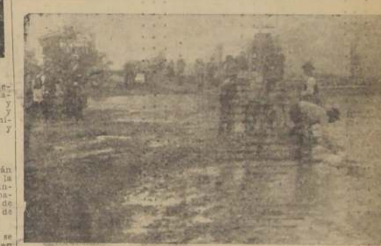
Haciendo la base de concreto en Avenida Cumming
