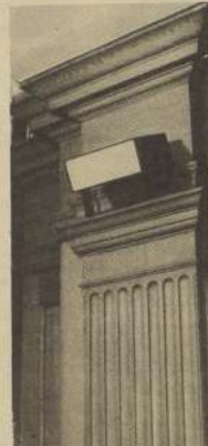
LA CIENCIA ATRAPA al ladrón. Detector de microonda (onda media) contra intrusos, instalado en un edificio.
