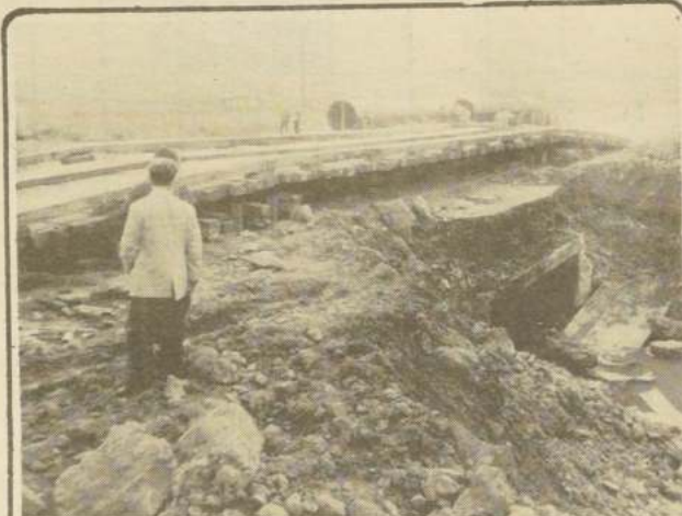
ESTADO ACTUAL de los trabajos de restauración del alcantarillado bajo la carretera, en el Km. 131.
