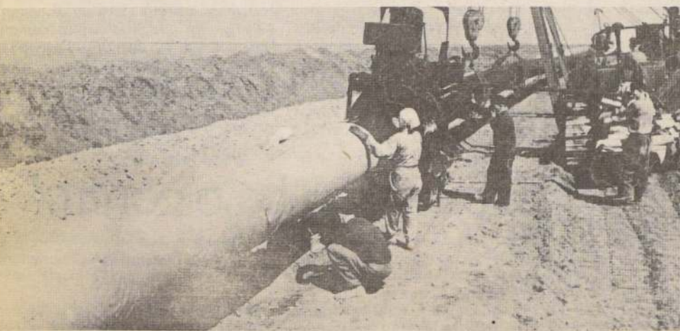
Durante la faena de instalación de la gran cañería de hierro a través del desierto, de 208 kilómetros de extensión, para la aducción de agua potable Calama-Antofagasta y zonas vecinas. Una obra gigantesca, que solucionó el problema de la escasez de agua en la zona.
