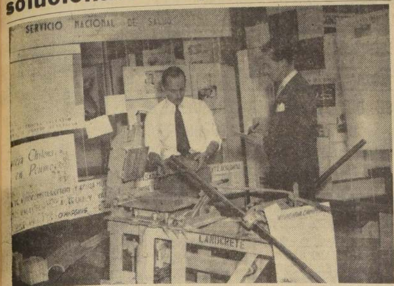
El arquitecto de la Corporación de Inversiones, señor Carlos Barrella, demuestra prácticamente a nuestro redactor, el funcionamiento de una máquina bloquera, de las usadas en la experiencia de Peumo.
