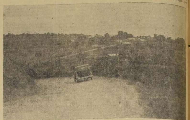
UN CAMINO DE RIPIO Y CHANCADO EN SAO PAULO (BRASIL) (Véase la inclinación del camino para evitar accidentes).
