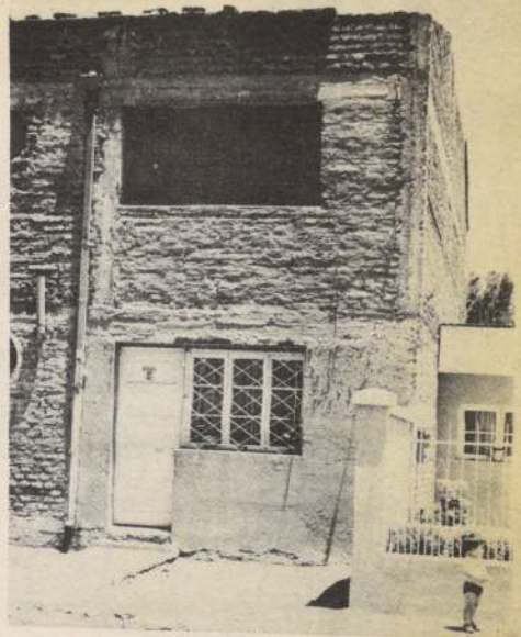
En el segundo piso de esta casa, ubicada en calle Bleriot 2516, está el cuarto de baño donde murieron asfixiadas por gas las dos menores que se encontraban solas en el momento de la tragedia.
