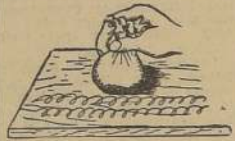
Relleno de los defectos de la madera
