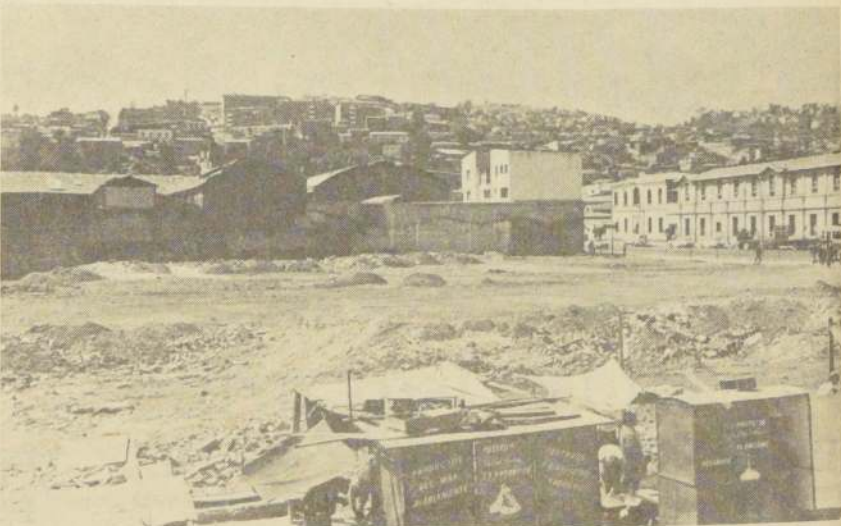
Terminaron las faenas de emparejamiento del extenso sitio erazo ubicado en las calles Rawson con Pedro Montt, donde próximamente se levantará un terminal rodoviario que involucraría todas las líneas de buses que se dirigen a la capital, norte y sur del país. La obra constituirá un gran avance dado que actualmente los buses se estacionan en la calle Errázuriz produciéndose un atochamiento en el sector de aduanas.
