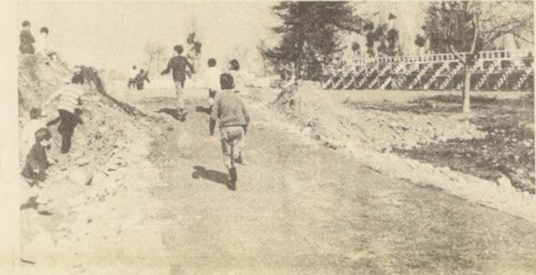
LA ALEGRIA de los niños sigue rondando en el destruido estadio. Ahora es necesaria la de los grandes para otra construcción.
