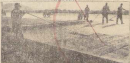
Vaciado de Hormigón Terminación
